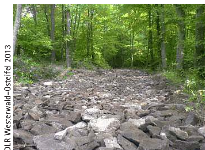
◀ Abb. 8: Wegebau in ver- nässten Bereichen mit sog. Krotzen
